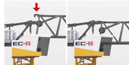
Ausleger an Kompaktkopf stecken und dabei halten/ Attach the jib to the compact head and keep in place
